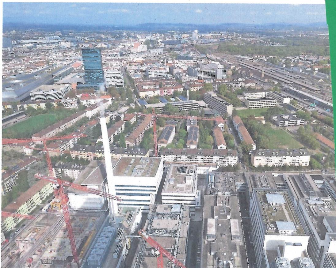
Traumhafte Aussicht und im Vordergrund bei den Kranen blickt man auf den entstehenden Turm 2.
